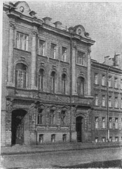
Дом на Кирочной улице, на третьем этаже которого размещалась подпольная типография газеты «Начало».
