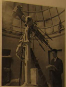
Гелиометр. В 1838 г. на таком же рефракторе фирмы Фраунгофера ( $D = 158$  мм;  $F = 2600$  мм) Ф.В. Бессель измерил параллакс звезды (близ Лебедя). Изображенный здесь инструмент фирмы Репольда установлен в 1891 г.
